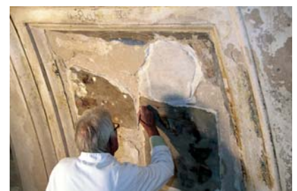
Wiederanbringung von Wandmalerei
