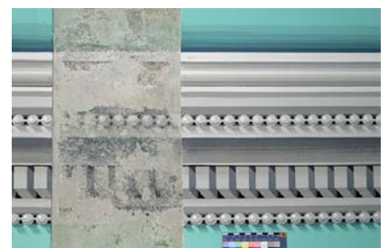
Restaurierung von Wandfassungen
